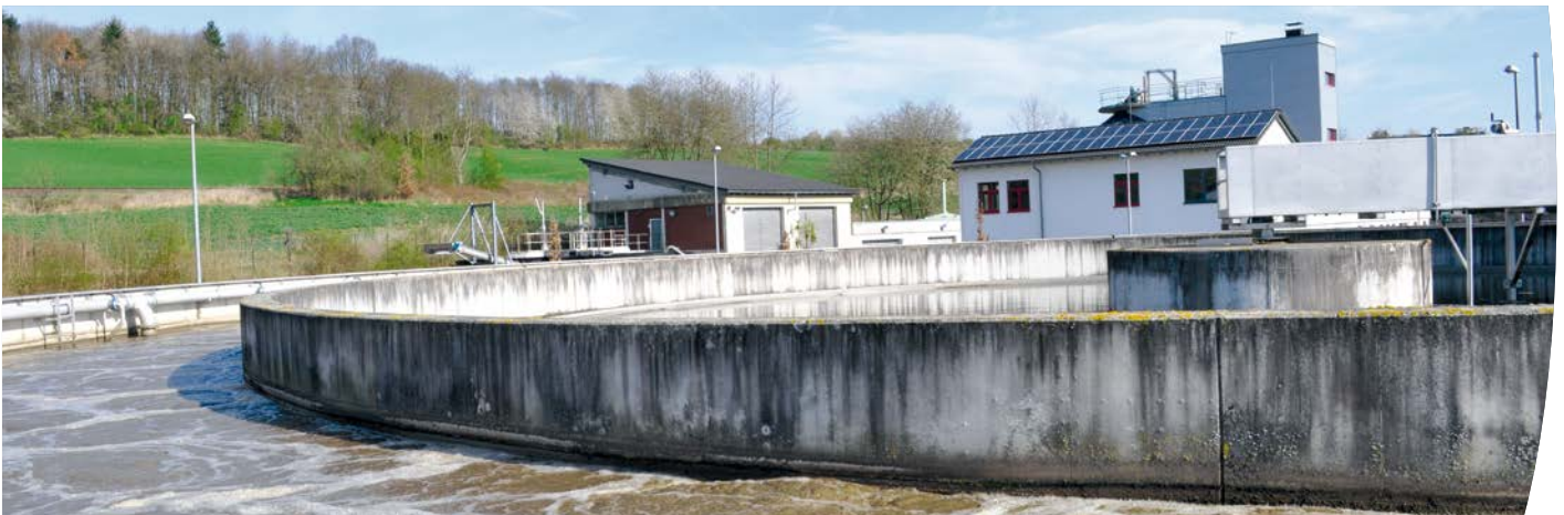
Die Kläranlage in Nidda produziert den Großteil ihres Strombedarfs selbst.
