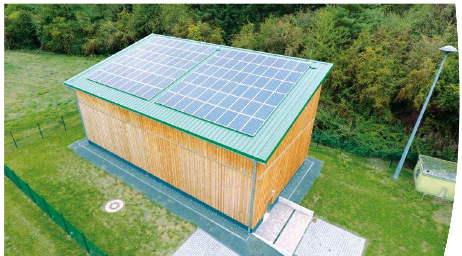
Hochbehälter mit Photovoltaik-Anlagen in Trais-Horloff, Bildrechte: Ingenieurbüro Müller GmbH & Co. KG.
